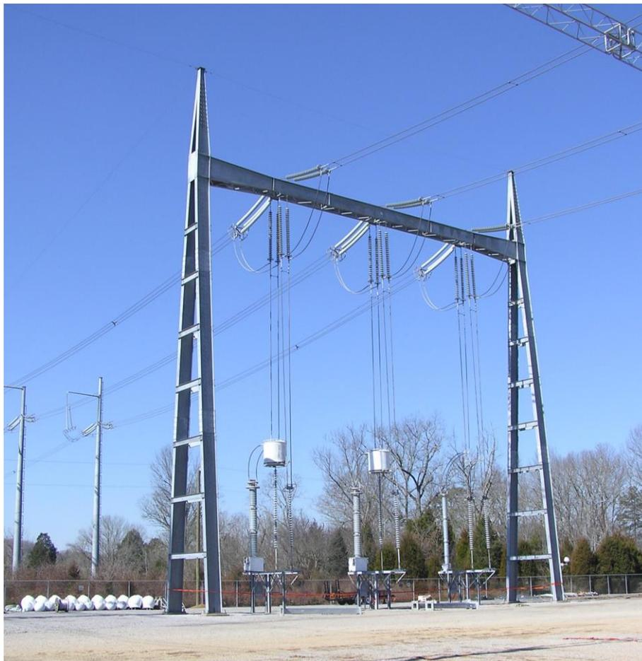
Figura 9.19: Sistema portador de línea en 500 kV con dos fases
